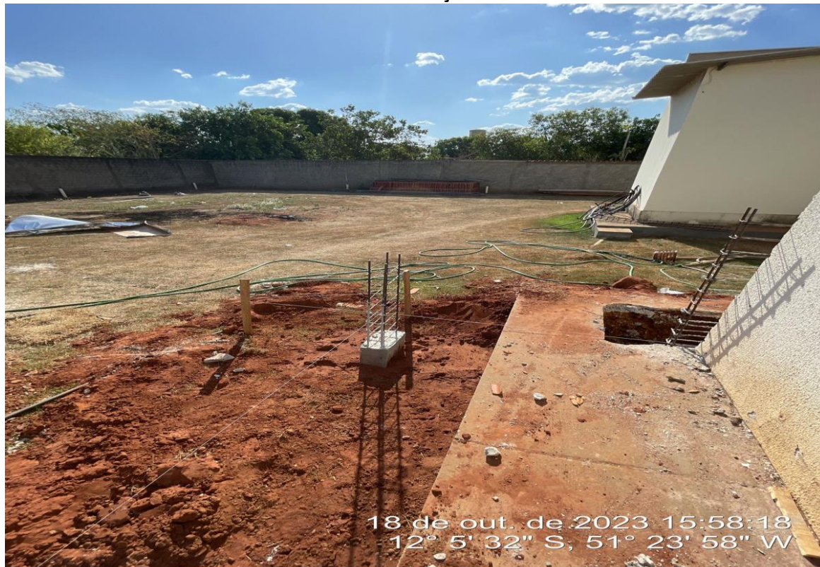
FOTO 10 – CONCRETAGEM E REATERRO DE FUNDAÇÃO
