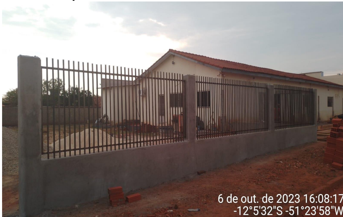
FOTO 12 – EXECUÇÃO DE GRADIL EM METALON
