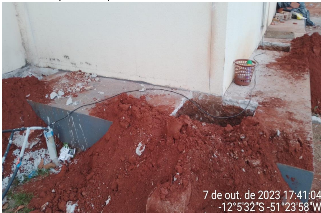
FOTO 05 – ESCAVAÇÃO SAPATAS;
