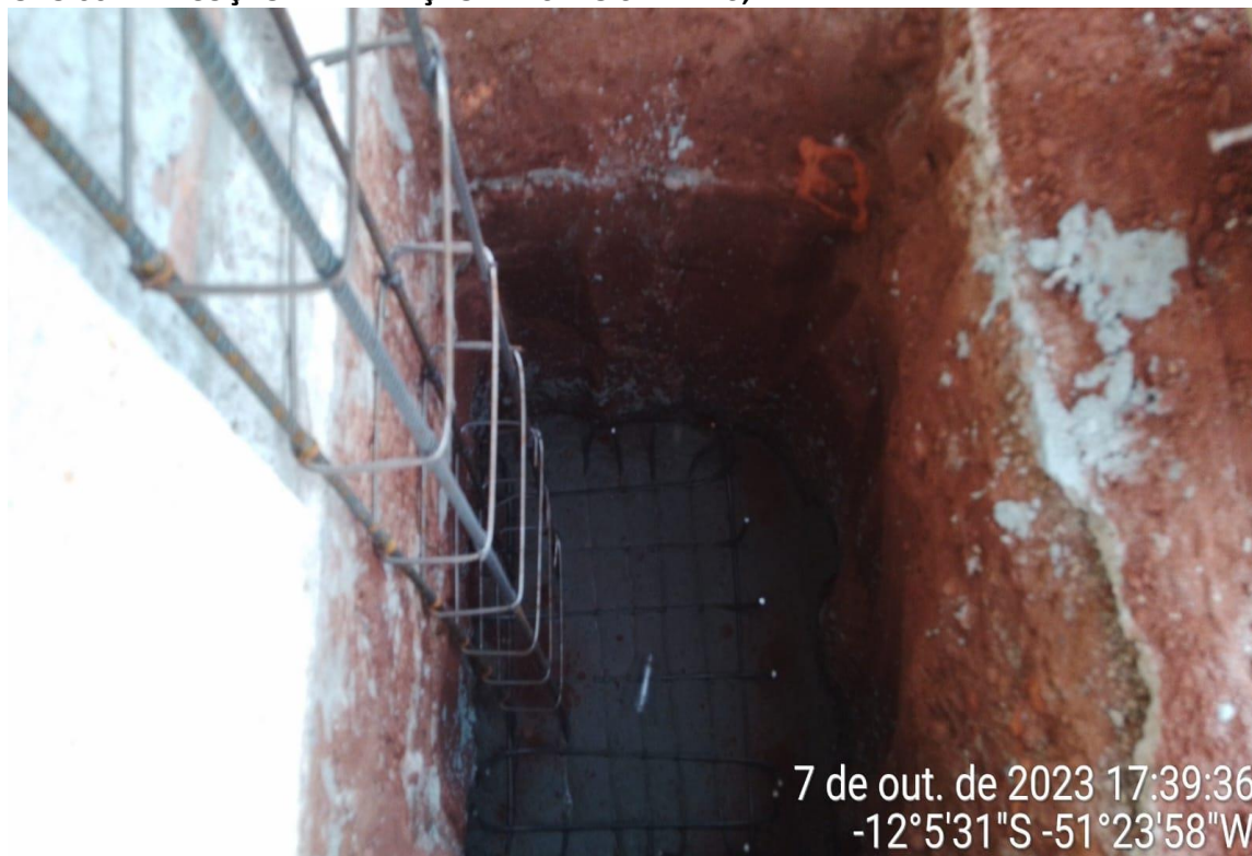
FOTO 06 – EXECUÇÃO DE ARMAÇÃO E LASTRO SAPATAS;
