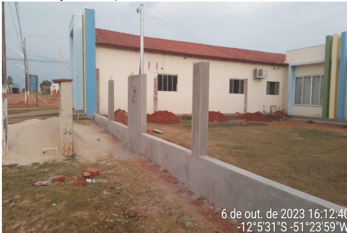
FOTO 08 – EXECUÇÃO DE MURO;
