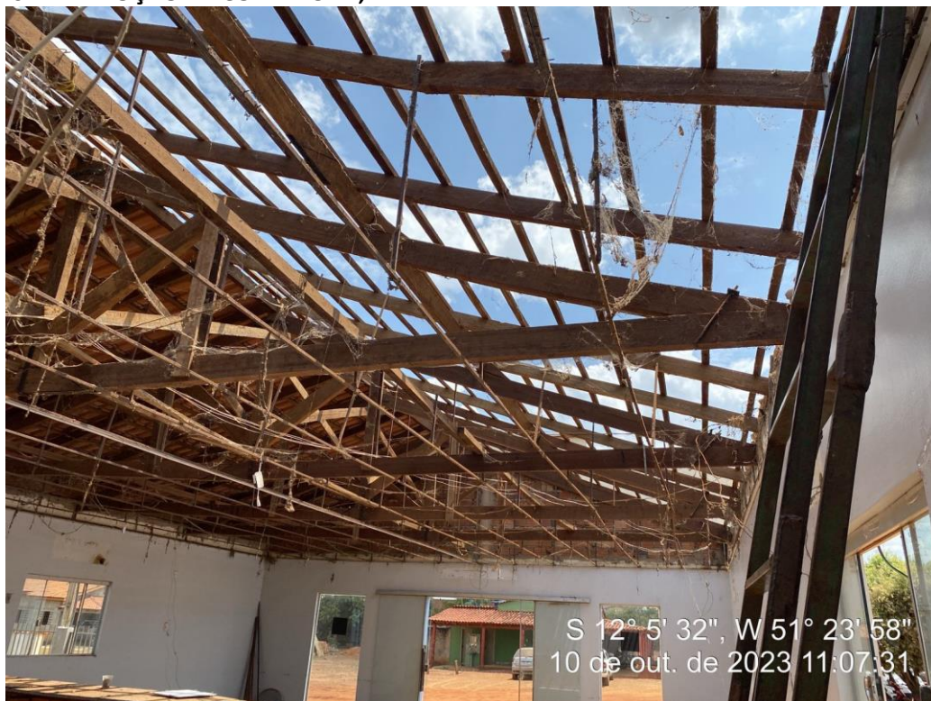
FOTO 02 – REMOÇÃO DE COBERTURA;
