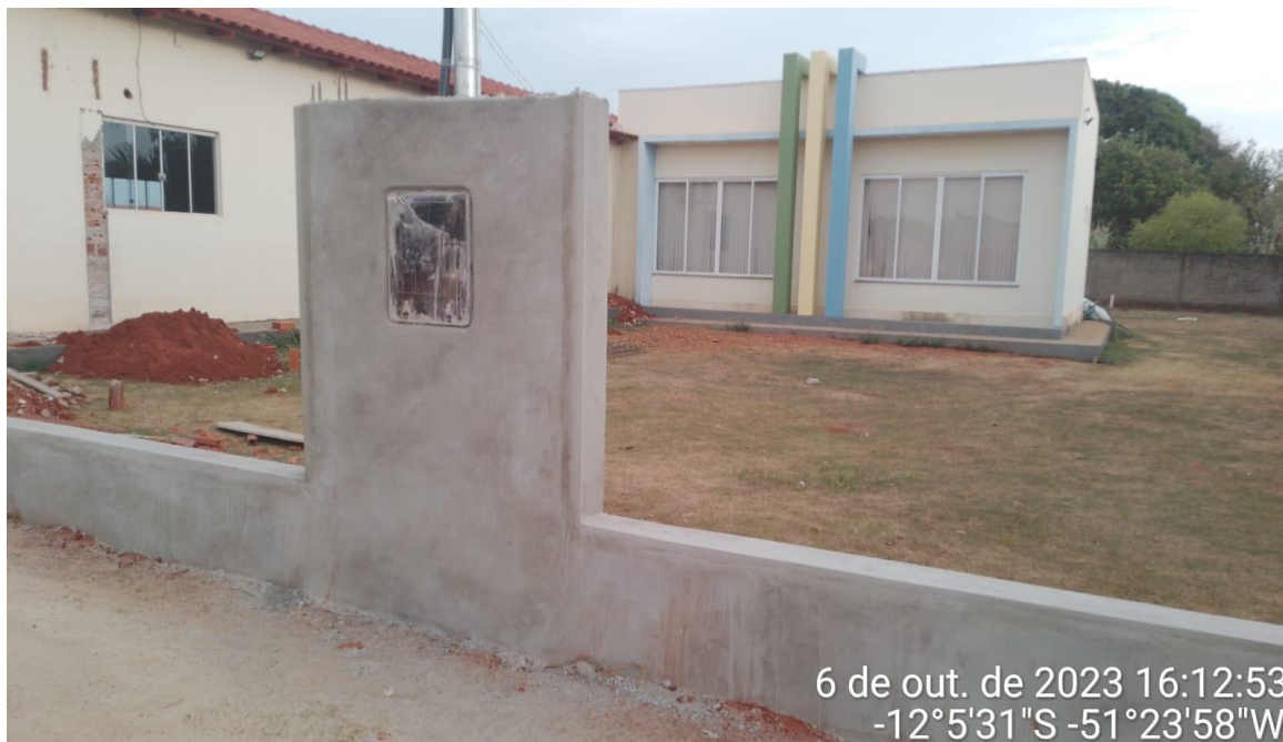
FOTO 09 – MURETA E PADRÃO DE ENTRADA DE ENERGIA
